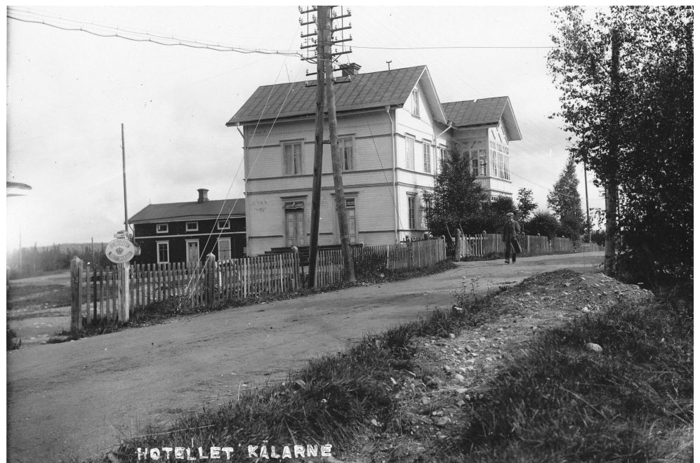
Hotellet efter A O Frändéns ombyggnad. Bilden tagen från ung. samma plats som ovanstående.
